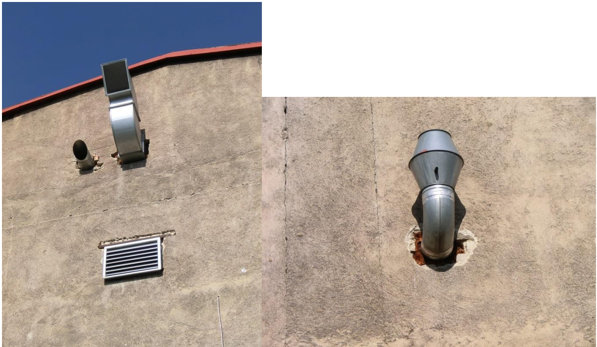
Obr. 3 a 4: Poškození zdiva na jižně orientovaných stěnách kolem ventilačních prvků.
