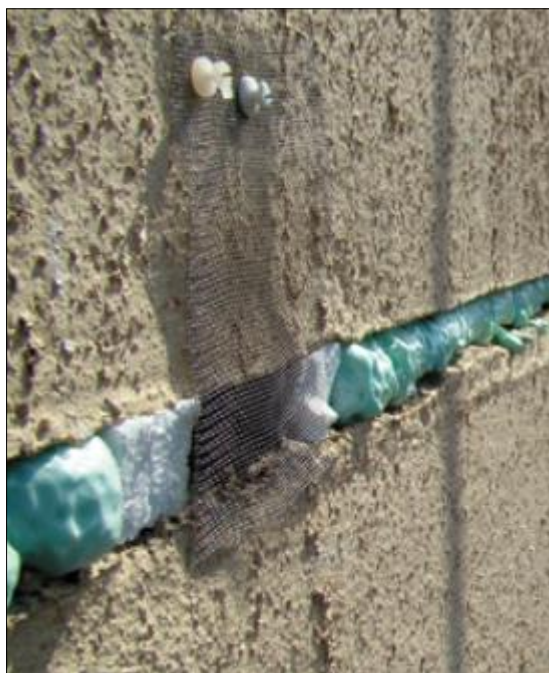
Obr. 34: Jednosměrná uzávěra. Síťka musí těsně přiléhat ke stěně domu a přesahovat otvor ze všech stran min. o 5 cm.
