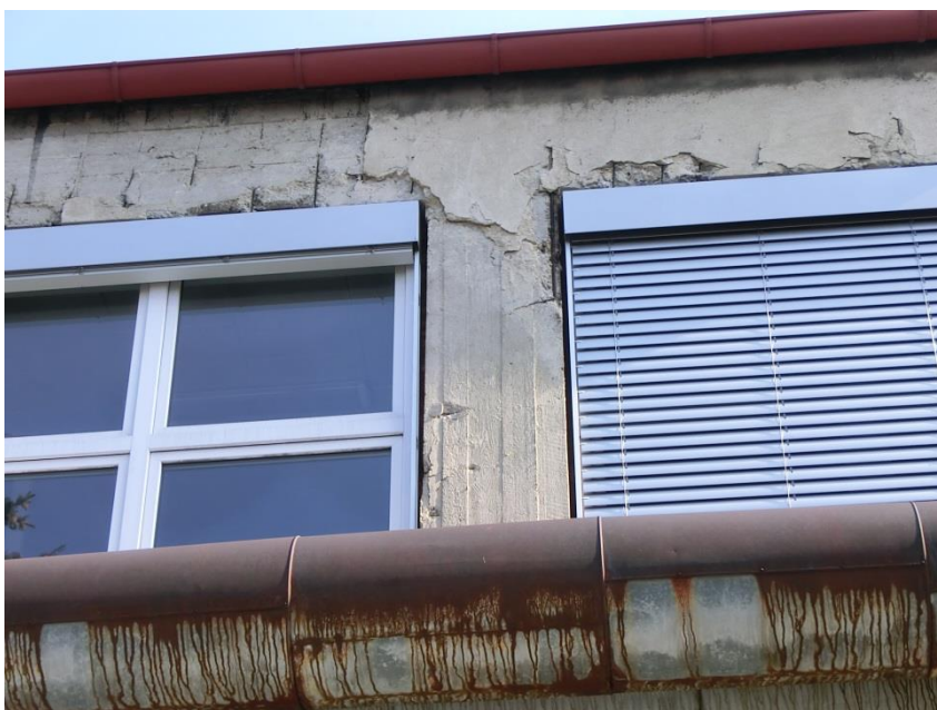
Obr. 11: Západní křídlo budovy západně orientovaná stěna – štěrbiny kolen vnějších žaluzií detail.
