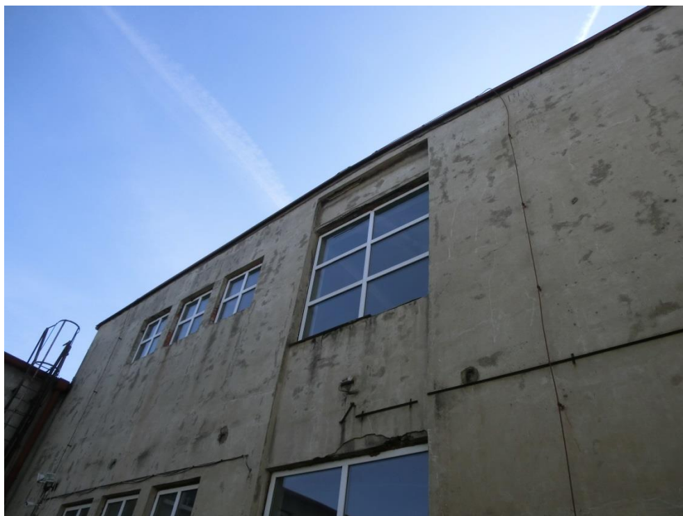
Obr. 12: Poškození zdiva na západním křídle budovy severně orientovaná stěna.
