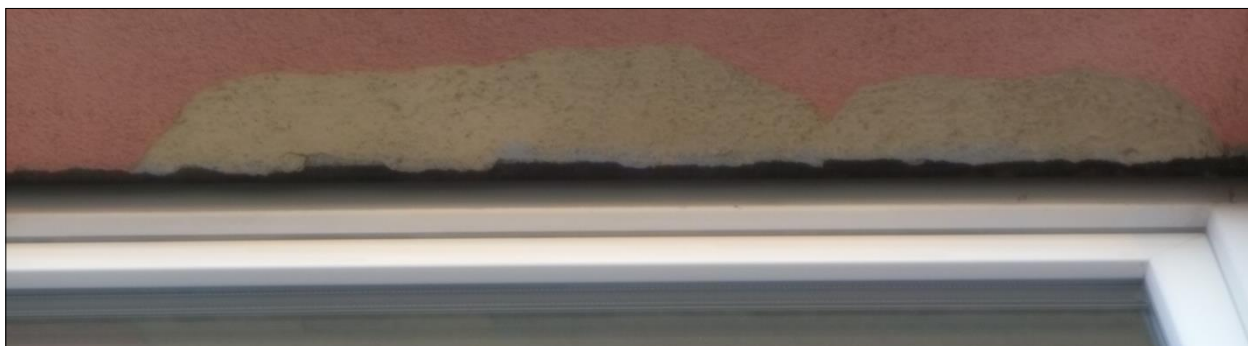
Obr. 20: Štěrbiny kolem oken.
