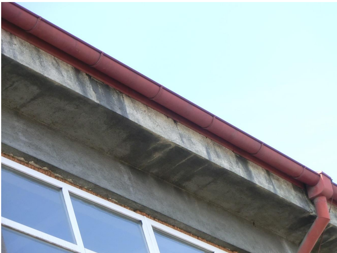
Obr. 5: Poškození zdiva pod oplechováním po obvodu střechy.
