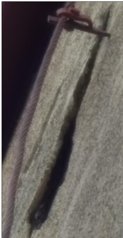
Obr. 23: Štěrbina kolem okna (vlevo)
