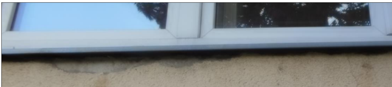
Obr. 21-22: Štěrbiny pod oplechováním střechy (nahore), pod parapetem (dole), kolem okna (vlevo).
