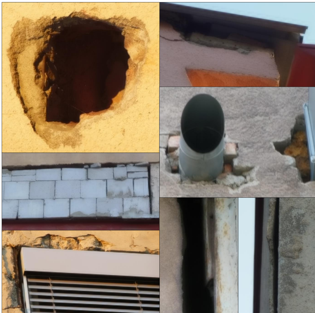
Obr. 13-19: Štěrbiny a dutiny ve zdech.
