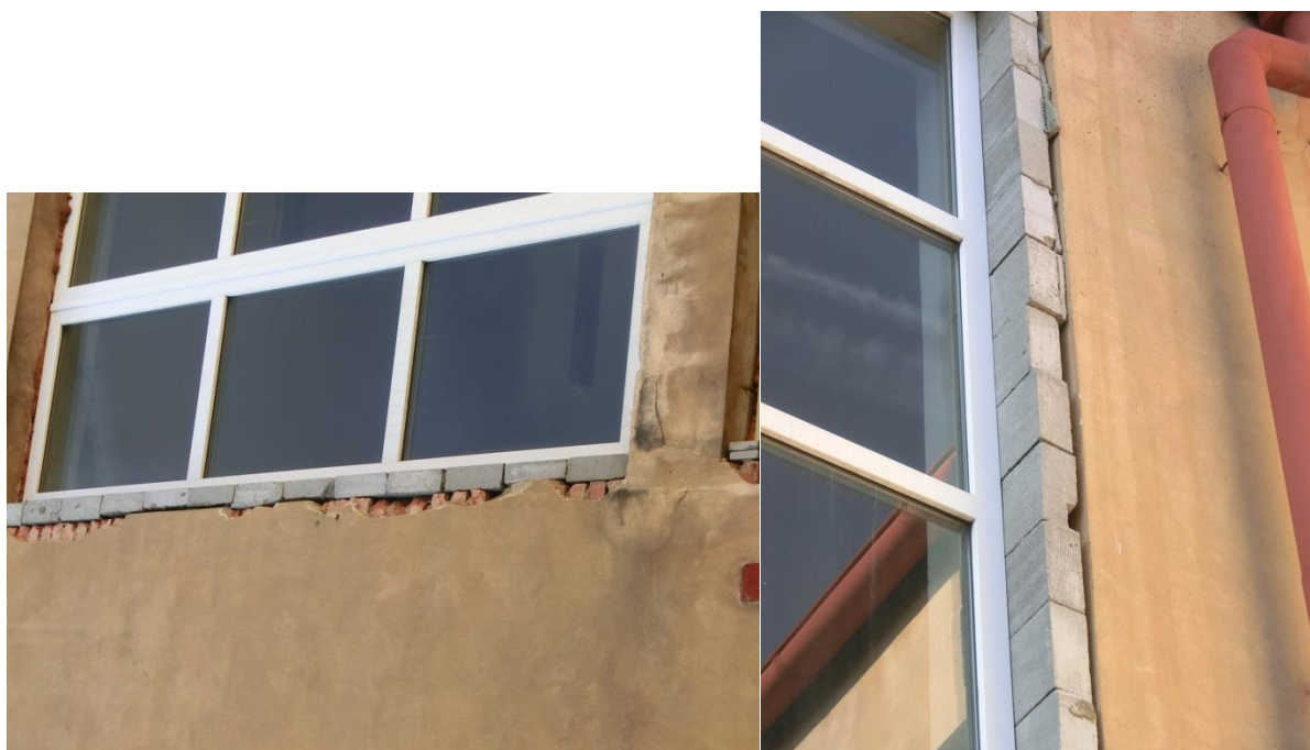
Obr. 9: Detail štěrbin mezi zdívem podél oken na západním křídle budovy východně orientované stěně.
